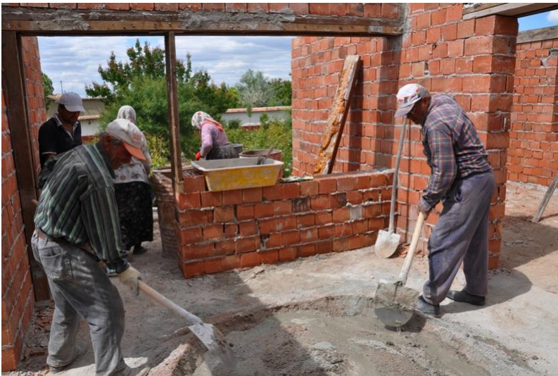
Fotoğraf-6: İnşaatı devam eden konut (Ördekgözü Köyü)
