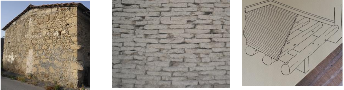
Şekil 4: Kırsal Konut malzemesi; taş ve kerpiç. Fotoğraf ve çizim: L.Çınar Algül.
