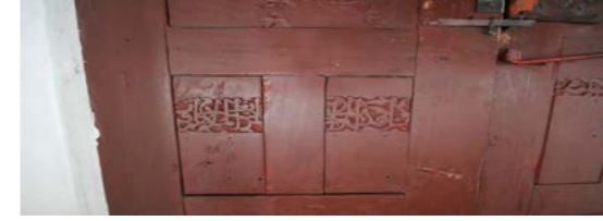
3.Kapı Kanatlarının İç Yüzeyinde Yer alan Kitabe
