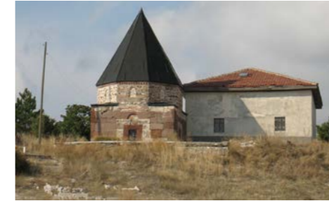
Cami ve Türbeye güneyden bakış
