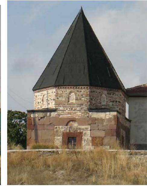
Türbenin güney cephesi
